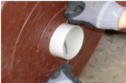
6. 배기관 하단에 고정핀 설치 및 고정
